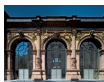
18 Renovation «Alte Post», Pirmasens/DE
