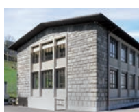
10 Pumpwerk Schöna, WVRB AG, Bern/CH
