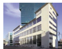
6 Umbau Bürogebäude «Diagonal», Zürich/CH
