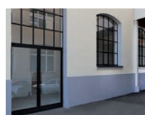
28 Heizhaus Brosswaldengasse, Bregenz/AT
